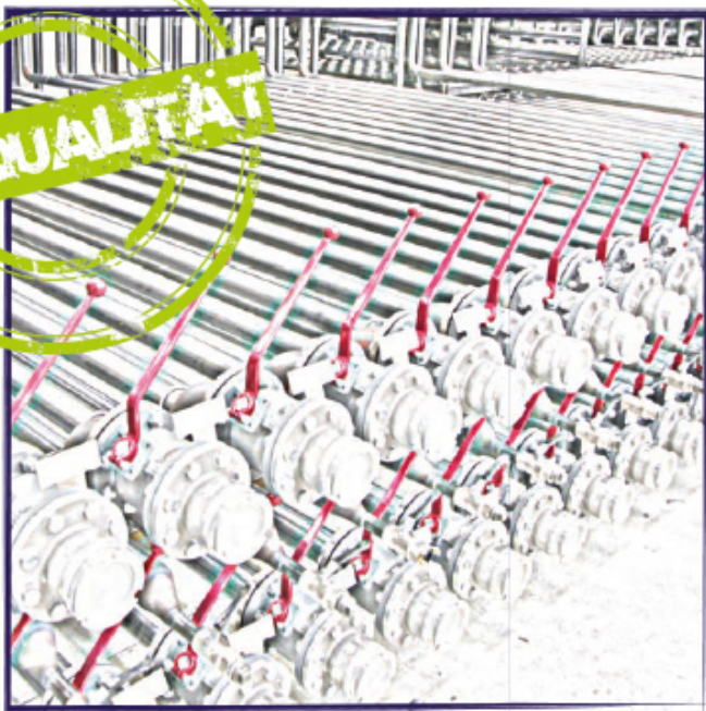
Für Additive und Basisöle sind Leitungen und Tanks fest zugeordnet.
